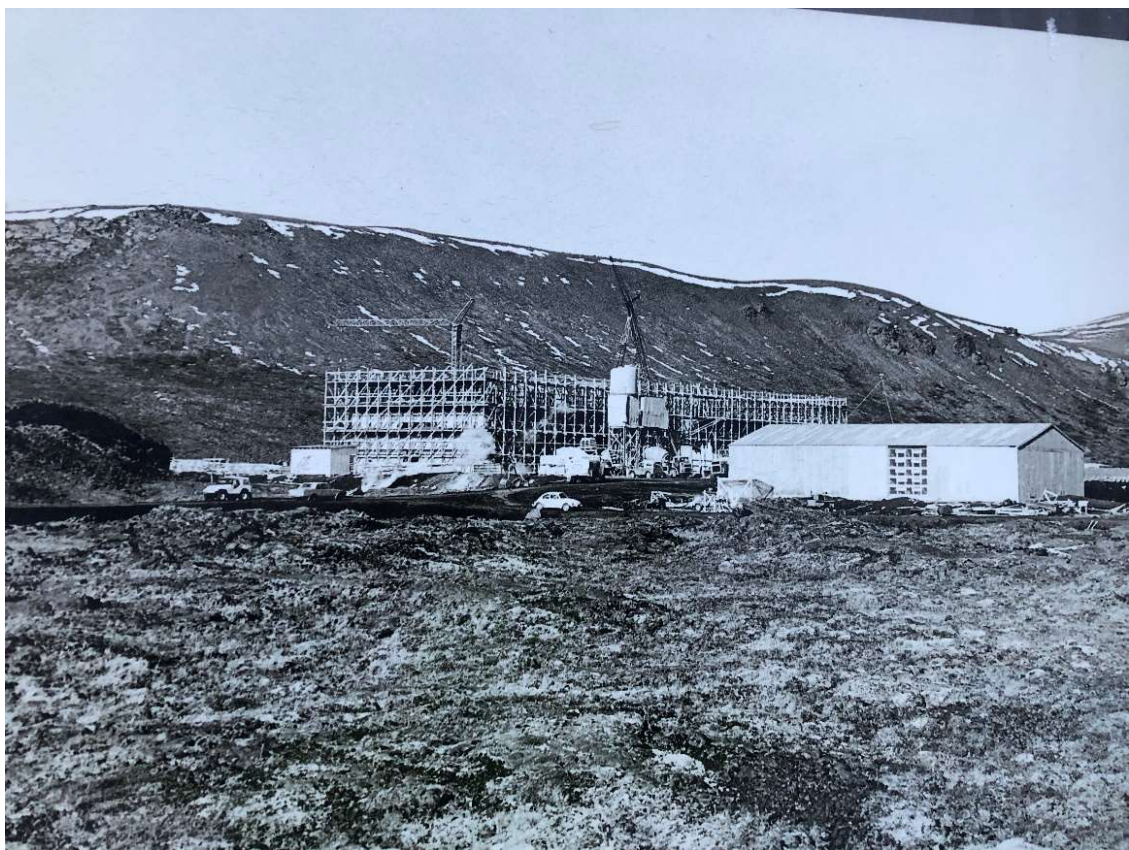
Mynd 2. Mynd frá framkvæmdartíma Kröflustöðvar. Við undirbúning borunar KN-01 fannst óvænt botnplata húss, en þegar það var kannað betur kom í ljós að skemna hafði staðið á þessum reit við byggingu virkjunarinnar.
